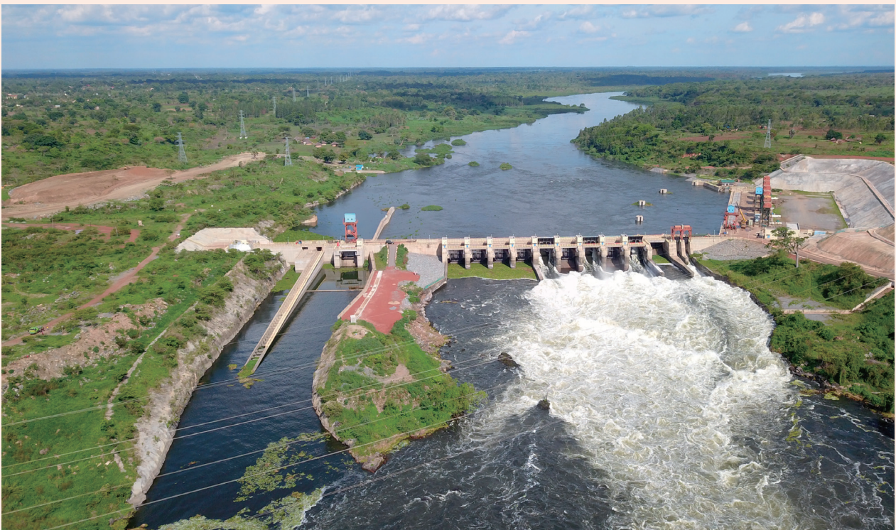
14 de diciembre de 2024. La planta hidroeléctrica Karuma, construida por China, en Kiryandongo, Uganda. El 6 de febrero de 2024, Uganda lanzó con éxito la última unidad de seis turbinas en la planta hidroeléctrica Karuma, construida por China, y la sincronizó en la red nacional, según informó la Agencia de Generación de Electricidad del país. Xinhua
