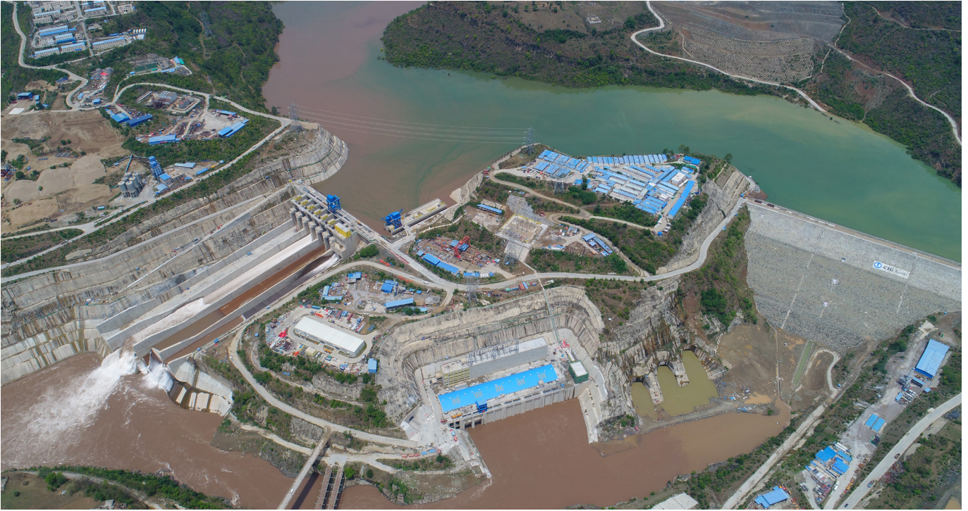
لقطة جوية تظهر مشهدا من محطة كاروت للطاقة الكهرومائية في مقاطعة البنجاب شرقي باكستان في ٢٢ يونيو ٢٠٢٢. (شينخوا)
